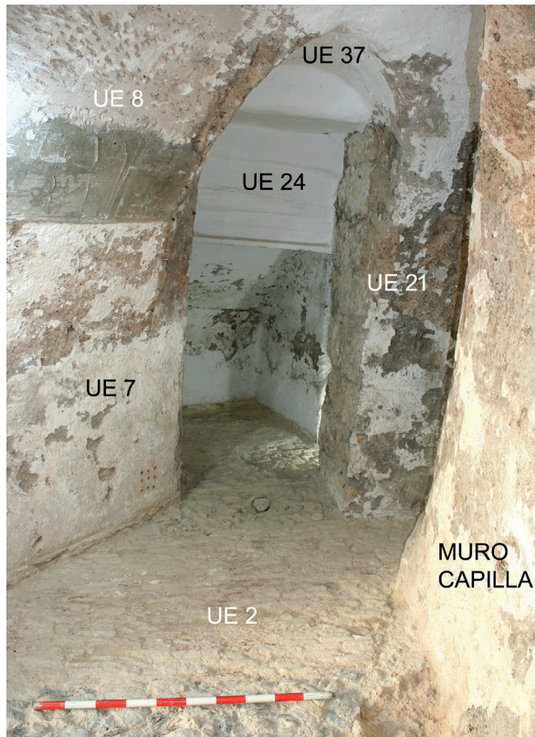
Fig. 8: Visual desde el Espacio A al Espacio B, una vez retirado el pavimento UE 1. A la derecha, el muro de la capilla (1731-1760). Las UUEE 7, 8, 21 (reutilizada) y 37 (luneto) corresponden a la cripta del camarín-torre (c. 1788).
