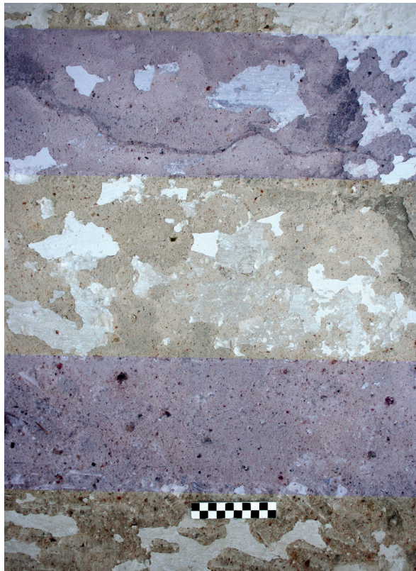
Fig. 9: Detalle de la bóveda barroca de la cripta (UE 8) donde se han señalado las huellas de la tablazón de la cimbra empleada para su construcción (c. 1788). El mortero es de yeso.
