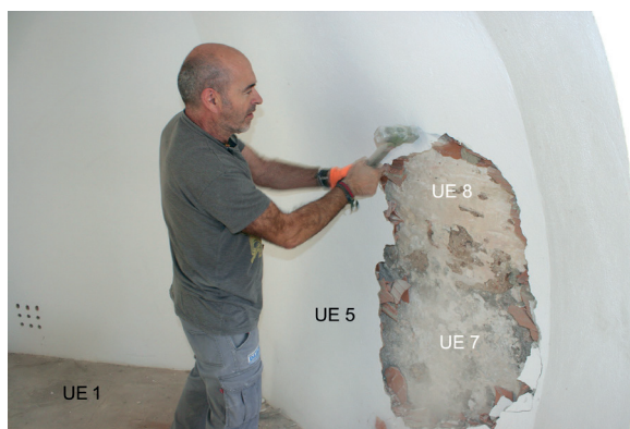
Fig. 7: Comienzo de los trabajos, con eliminación de la obra de finales del siglo XX (UUEE 1 y 5). Tras la cámara de aire aparece la obra barroca del siglo XVIII (UUEE 7 y 8).
